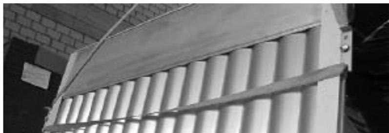
Der Kollektor wird auf dem S-Profil verschoben, bis der Kollektorhaken randbündig liegt. Die Hammerkopfschraube wird dann fest angezogen.
