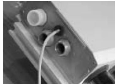
Der Fühler wird bis zum Anschlag, ca. 19 cm, in den Kollektor eingeschoben, die richtige Position für die genaue Temperaturerfassung.
