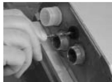
Auf der Kollektoreingangs- und Ausgangsseite wird der Fühler eingesetzt. Den Gummistöpsel durchstossen, beispielsweise mit einem 5 mm Bohrer.
