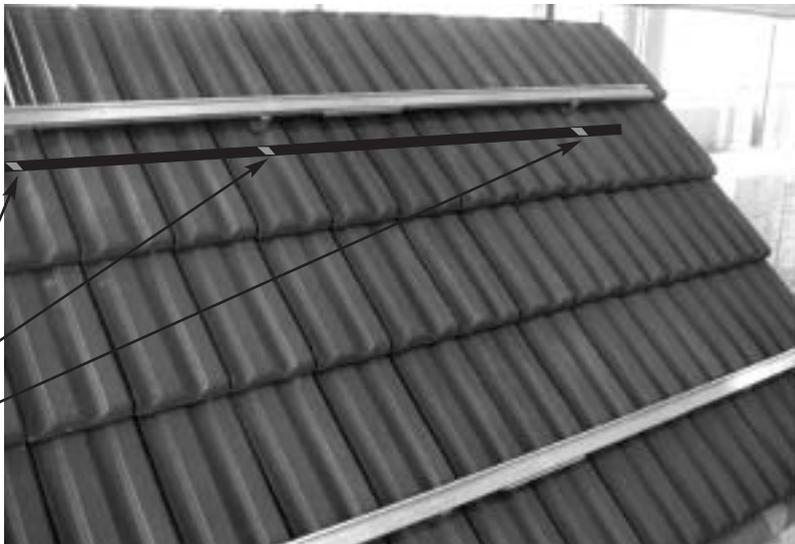
Den OPC 15 waagrecht auf eine praktische Arbeitshöhe legen. Für die Montage wird das Kollektorhakenset benötigt.
