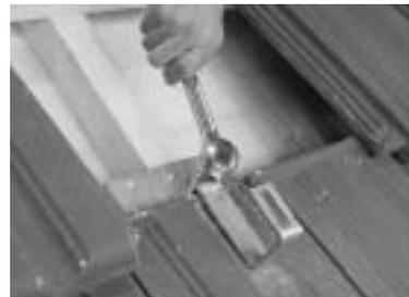
Festgeschraubter Montagewinkel mit zusätzlicher Holzunterlage für die richtige Ziegelhöhe. **12**
