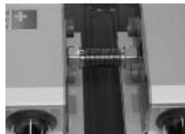
Der zweite OPC 15 Kollektor wird auf Kompensatorabstand gebracht und der Kompensator fest verschraubt. (Anzugmoment 30 - 40 Nm)
