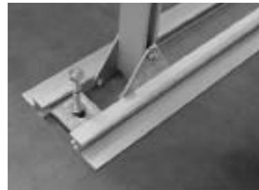
Am Schluss werden die 4 Klemmplatten – zwei vorne, zwei hinten – für die Befestigung am Rande des Kollektorfeldes verschraubt. Die Platte ebenfalls bis zum Anschlag an den Nutenstein heranschieben.
