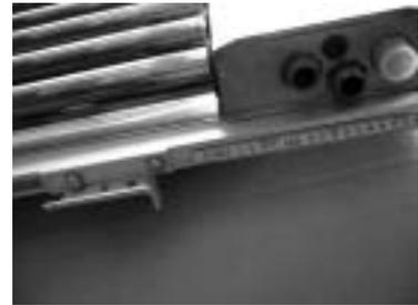
Die beiden Kollektorhaken am Kopfteil werden mit dem Meter genau eingemessen.
