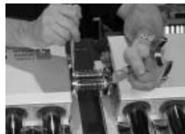
Alle Kompensatoren müssen gegengleich angezogen werden um einseitiges Durchdrehen zu verhindern! (Anzugmoment 30 - 40 Nm)
