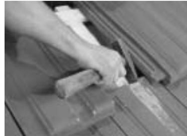
Montagewinkel passend einlegen und die Bohrlöcher mit den Holzschrauben positionieren, sowie die Löcher mit ca. 5.5 mm vorbohren. **10**
